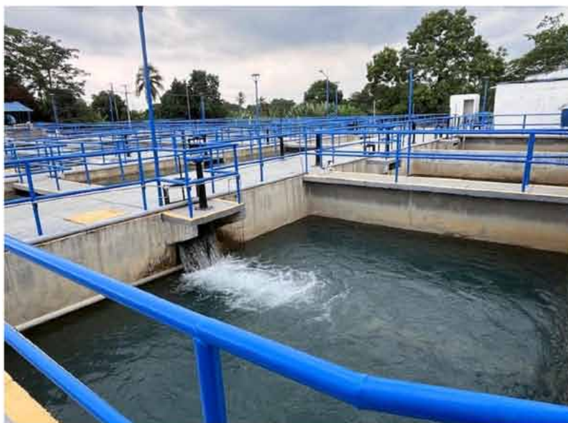
Planta de agua de Aqualia. / Foto: Aqualia.
