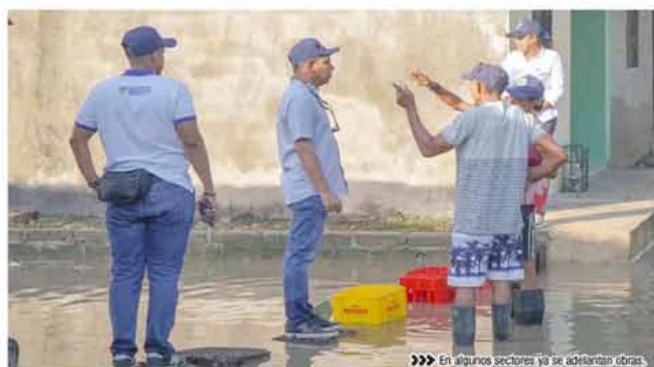
»»» En algunos sectores ya se adelantan obras.
