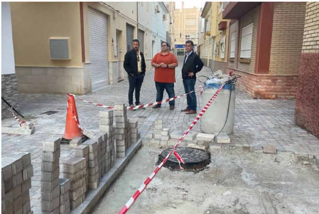
Inmediaciones de la obra de saneamiento en la calle Joaquín Turina en Torrenueva Costa | Foto: Gabinete
