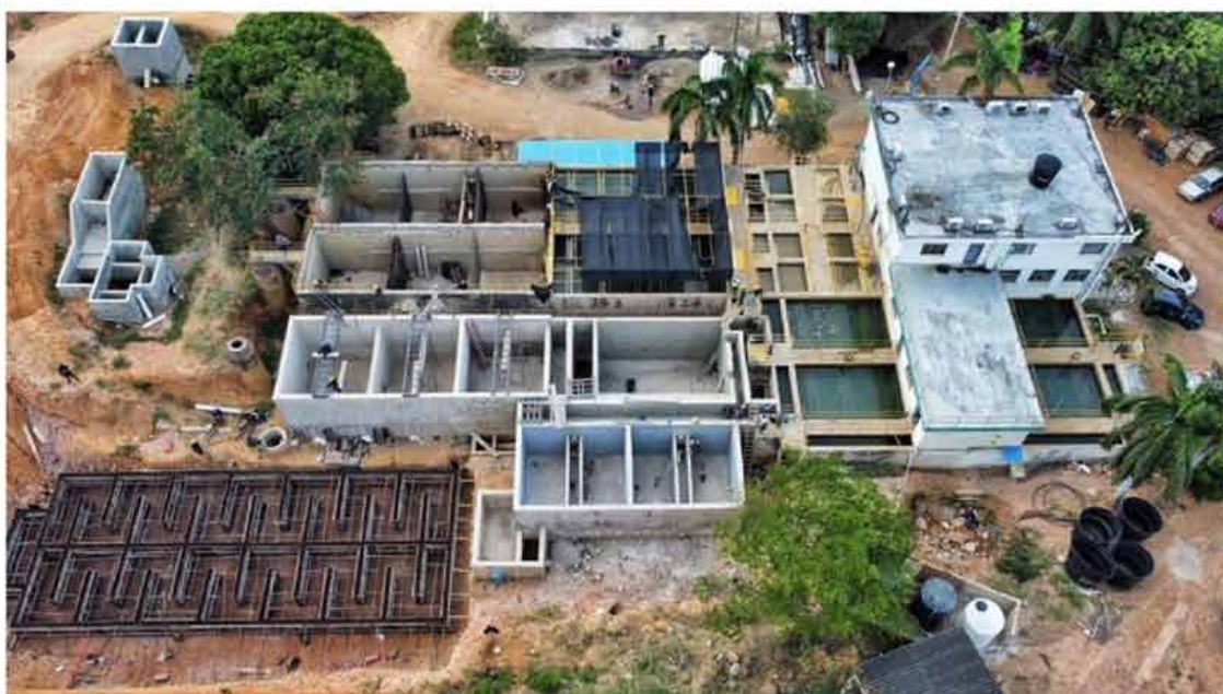
Aqualia avanza con las obras de ampliación y optimización de la planta potabilizadora en Villa del Rosario
