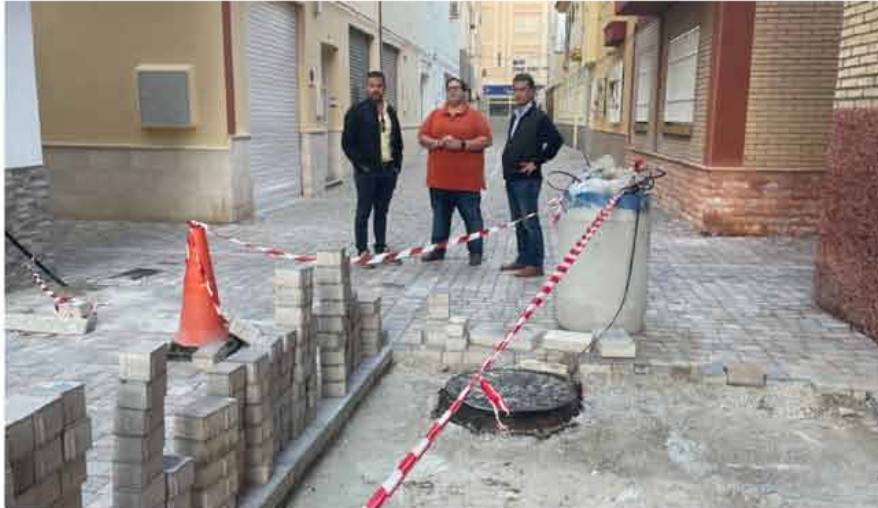
Inmediaciones de la obra de saneamiento en la calle Joaquín Turina en Torrenueva Costa | Foto: Gabinete
